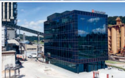
Maximale Energieeffizienz und Ästhetik vereint: Innovative und hochleistungsfähige Glas-Glas Solarmodule sorgen bei SWISS KRONO für unabhängige Energieproduktion und einen unverkennbaren ästhetischen Auftritt des Hauptsitzgebäudes. Die Hochleistungsmodule kombinieren die markt- und industrieführende MB PERC Zellbeschichtungstechnologie mit Smart-Wire Connection Technologie. Spitzentechnologie, am Technologie- und Produktstandort von Meyer Burger in Thun entwickelt und gefertigt.
